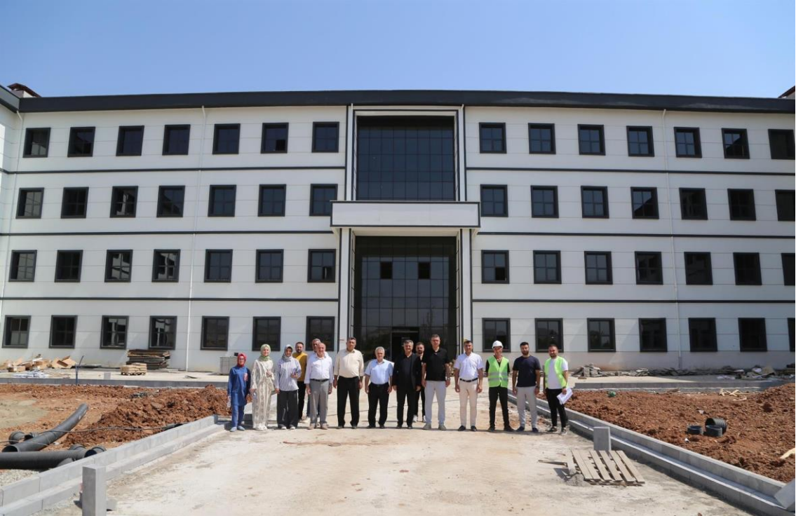
Yeni binanın inşaat süreci
