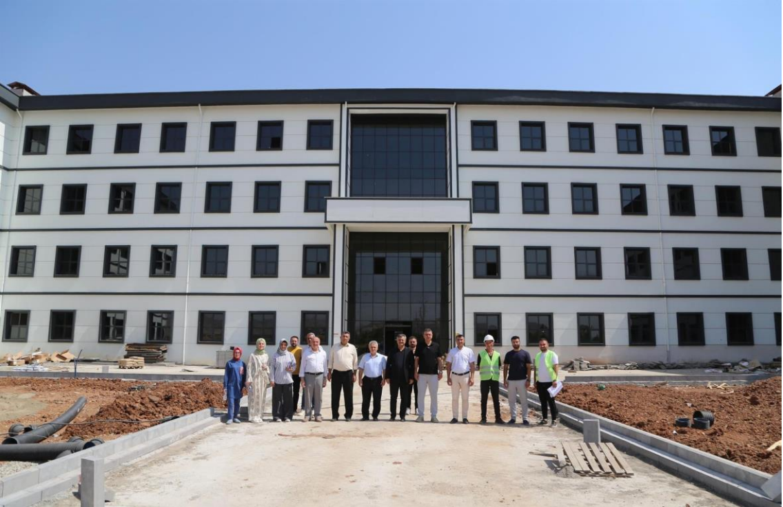
Yeni binanın inşaat süreci
