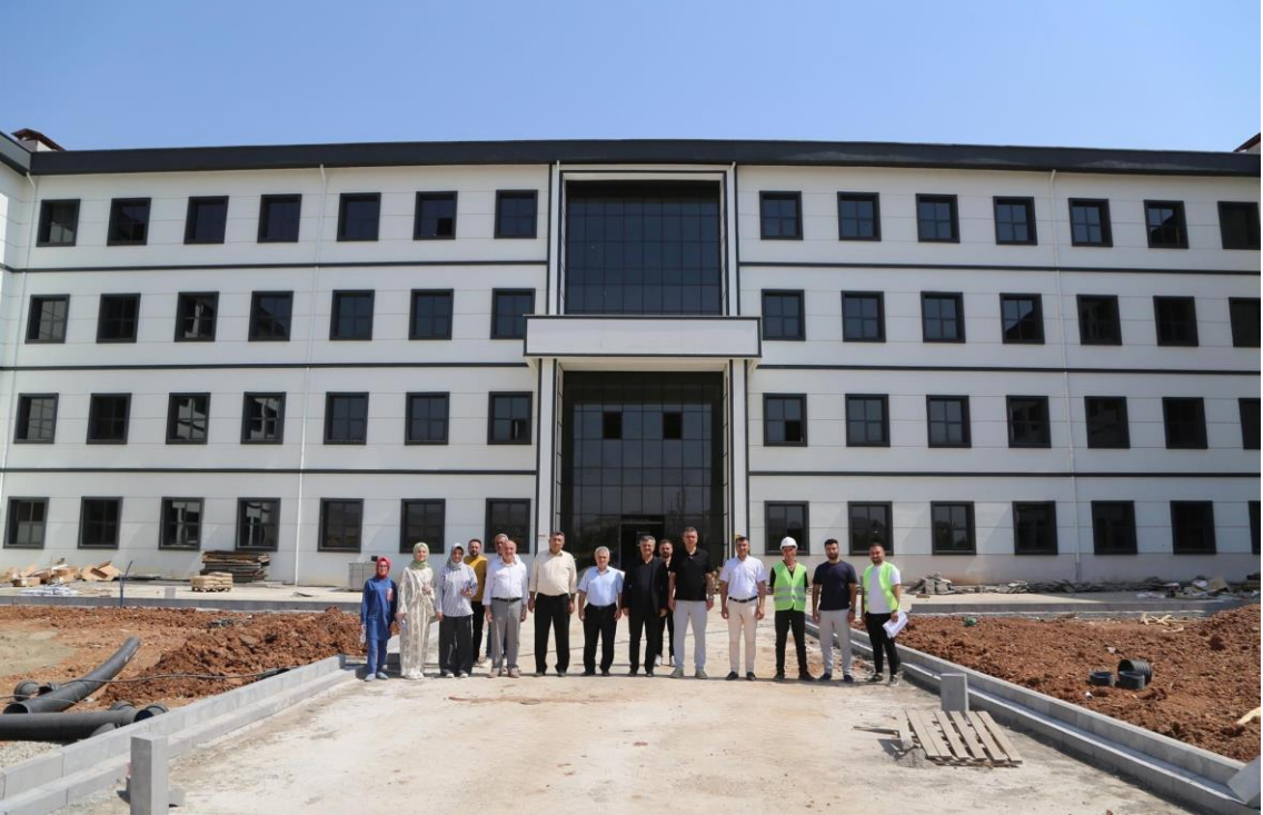
Yeni binanın inşaat süreci
