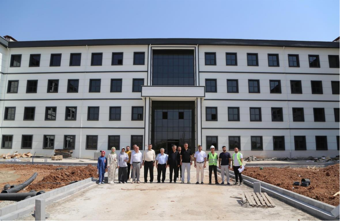
Yeni binanın inşaat süreci
