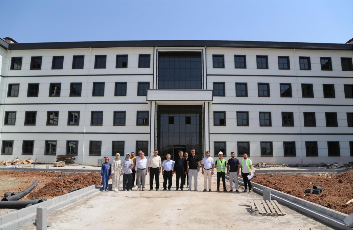
Yeni binanın inşaat süreci
