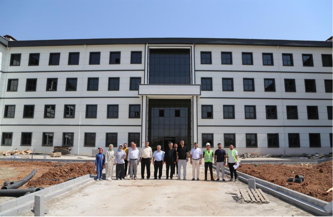
Yeni binanın inşaat süreci
